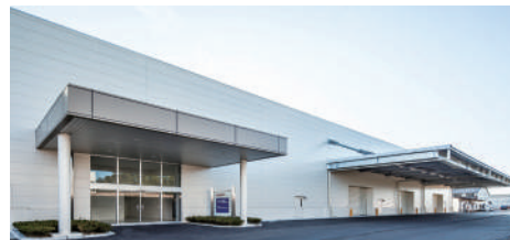
ロボット第3工場(富山)
