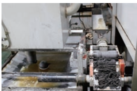
図3 旧フィルトレーション装置
